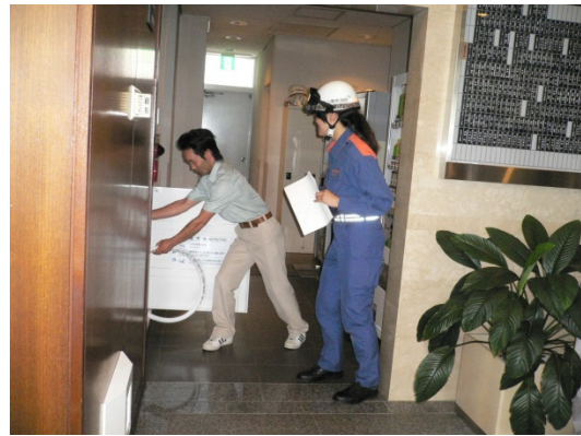
・消火栓の初期操作による非常用消火栓開放
