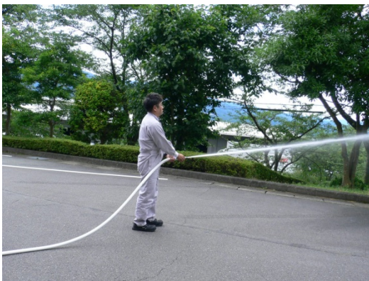
・室内消火栓による放水実施
